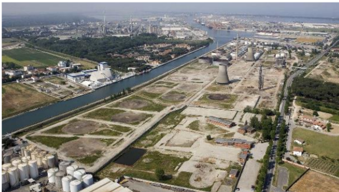
Una vista dall'alto della zona acquisita dall'Autorità portuale per installare una distesa di pannelli solari
